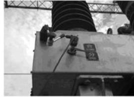
33KV SF6 开关传感器安装
